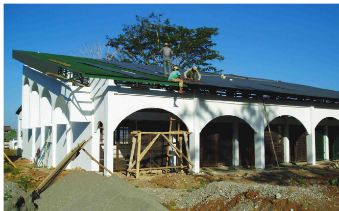
Tabajos de reconstrucción financiados por la AECID en la Escuela Técnica de Maliana, en Timor Oriental. © OTC Indonesia y Timor Oriental
